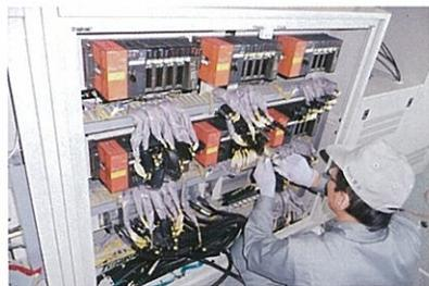
【写真2】 PLC交換作業
