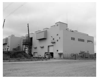
【系統用蓄電池設備 建屋外観】
