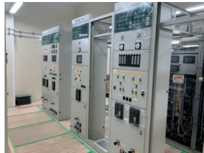
【現地据付された回線制御盤】
